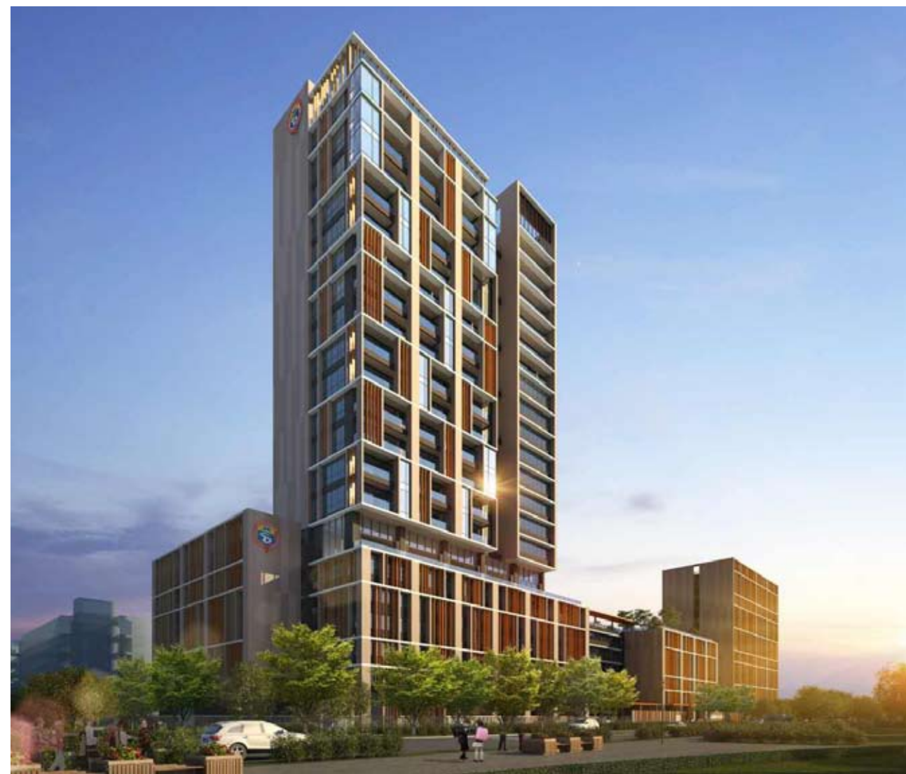
▲ 正在建设的广东顺德德胜学校小学部的平面立体透视图（2017年启用）
